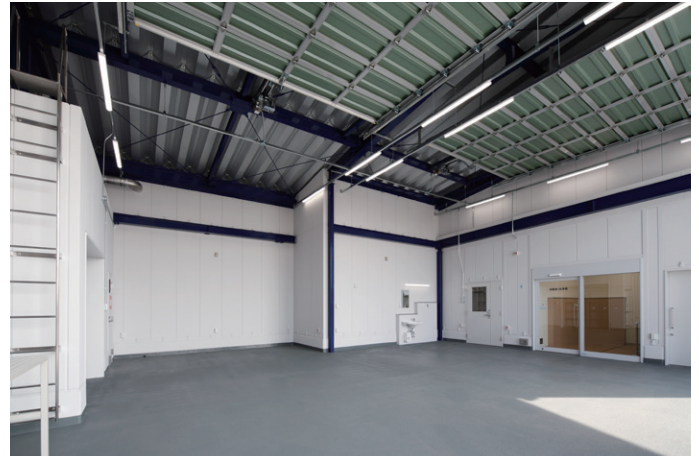
緊急車両車庫
